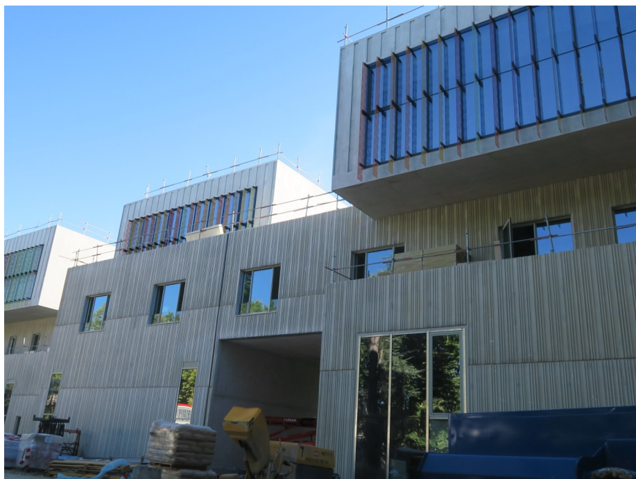
Vue façade Ouest du futur Conservatoire
